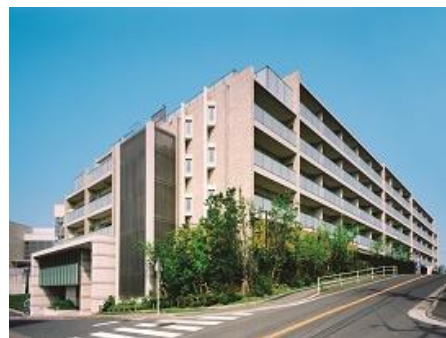
グランクレール藤が丘ケアレジデンス (土地：事業者非所有、建物：賃借)
