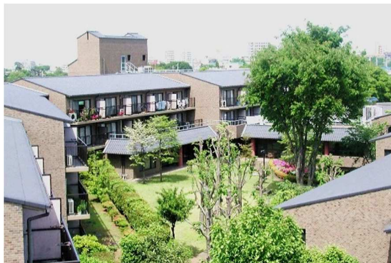
屋上からの中庭
