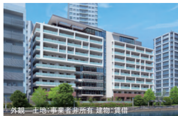
外観 土地:事業者非所有 建物:賃借 グランクレール芝浦
